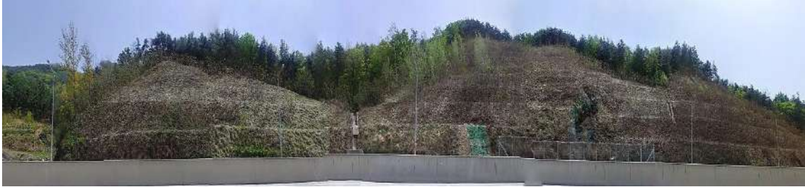
상주절토 02 (관리이정 2.240~2.510km / 1공구 STA.2+240~2+510)
