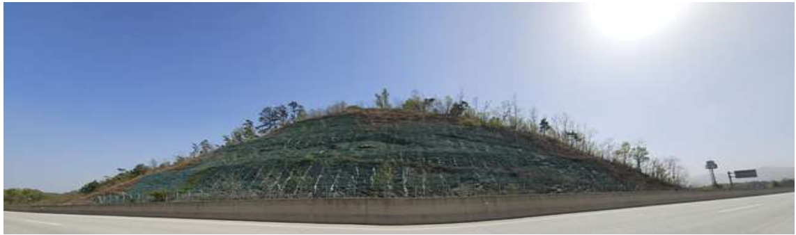
영천절토 46 (관리이정 70.058~70.418km / 8공구 STA.4+700~5+060)
