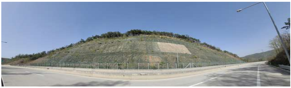
상주절토 35 (관리이정 0.160~0.42km / 6공구 STA.0+160~0+420(이설도로#2))
