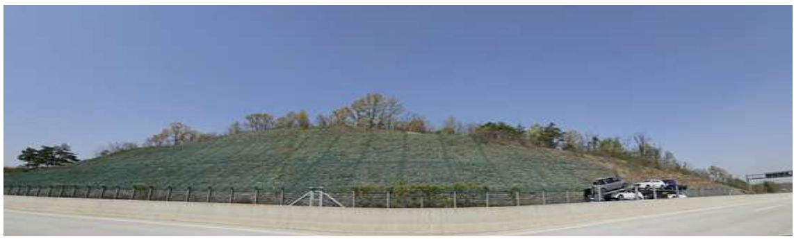
영천절토 51 (관리이정 72.378~72.588km / 8공구 STA.7+020~7+200)
