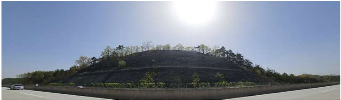
영천절토 54 (관리이정 74.338~74.518km / 8공구 STA.8+980~9+160)
