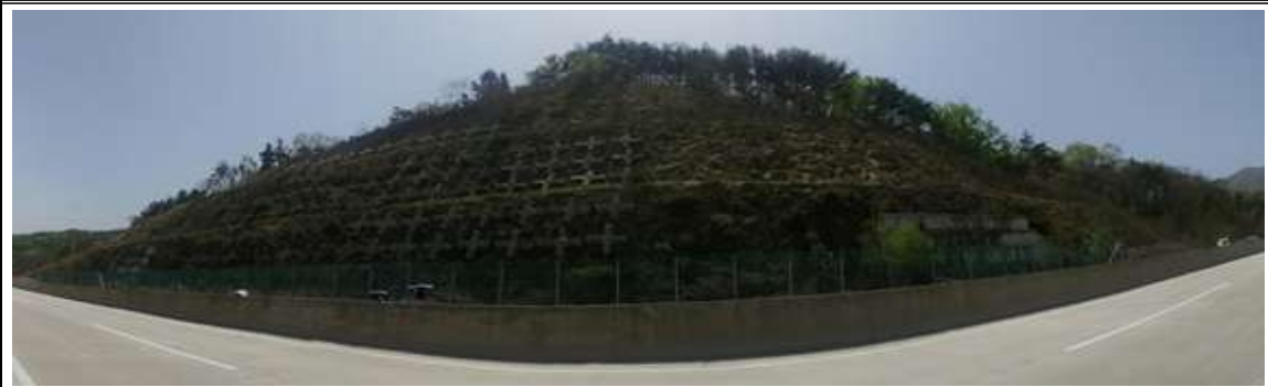
영천절토 19 (관리이정 24.754~24.974km / 3공구 STA.8+740~8+960)
