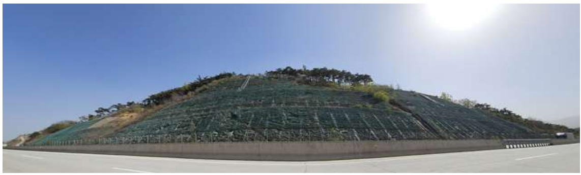
상주절토 47 (관리이정 70.498~70.778km / 8공구 STA.5+140~5+420)
