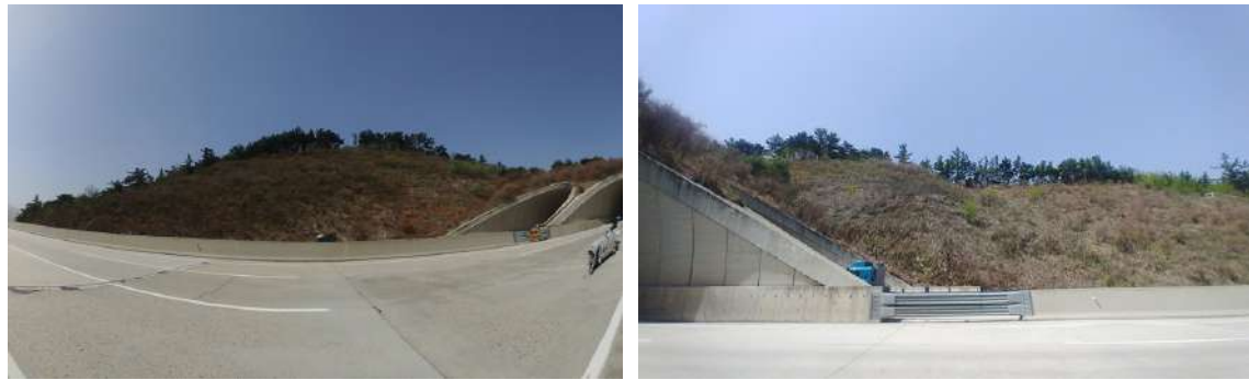
상주절토 03 (관리이정 3.540~3.830km / 1공구 STA.3+540~3+830)
