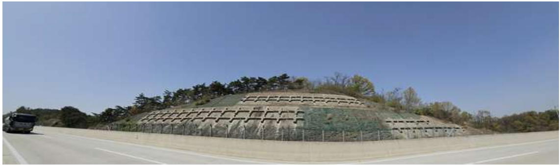
상주절토 50 (관리이정 71.71.478~71.718km / 8공구 STA.6+120~6+360)
