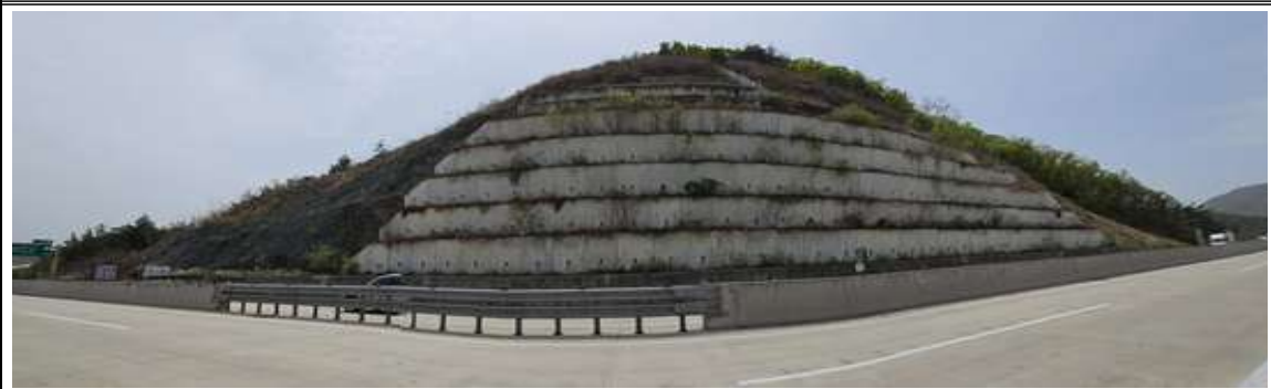
영천절토 20 (관리이정 25.854~26.074km / 3공구 STA.9+840~10+060)
