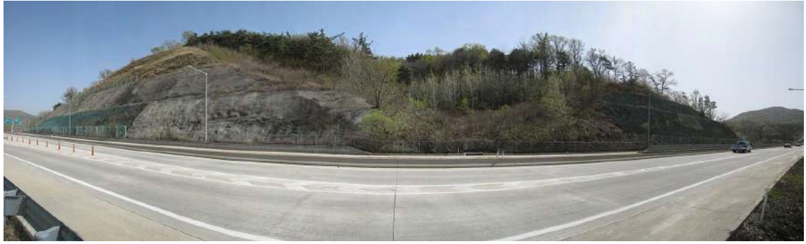
영천절토 34 (관리이정 1.890~2.150km / 5공구 군위R-A(중양)STA.1+890~2+150)
