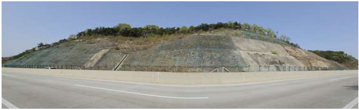
상주절토 30 (관리이정 38.525~38.685km / 5공구 STA.2+290~2+450)
