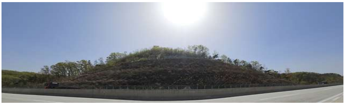
영천절토 55 (관리이정 74.758~74.938km / 8공구 STA.9+400~9+580)
