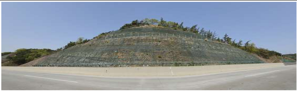
영천절토 31 (관리이정 40.025~40.175km / 5공구 STA.3+790~8+940)
